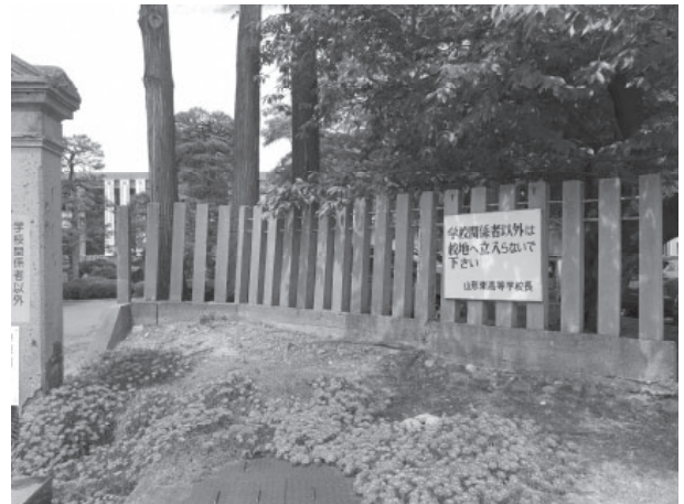
樹勢により倒壊の恐れのあるコンクリート製の列柵
